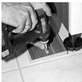
Die Verbindungselemente auf der seitlichen Sockelblende ausrichten.
