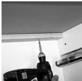
Verbinden Sie die Arbeitsplatte zunächst durch die vordere Traverseleiste mit dem Unterschrank.
