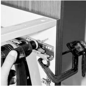
Da die Möbelteile mit einer Spaxschraube (ca. 30 mm) verbunden werden, sollten die Unterschränke zunächst vorgebohrt werden.
