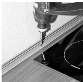
Die Befestigungsschiene wird bei Ecken auf Gehrung geschnitten und wandbündig auf die Arbeitsplatte geschraubt.
