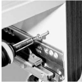
Achten Sie beim Verbinden der Schränke mit 3 Spaxschrauben darauf, dass die Korpusvorderkanten bündig sind.
