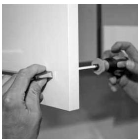
Zum Schluss montieren Sie noch die Griffbeschläge mit einem Handschraubendreher.
