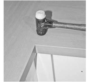
Bei einer Plattenverbindung setzen Sie die Holzplättchen in die Längsnut der Platten ein und bestreichen Sie die Stoßkanten vor dem Zusammenfügen mit dem beiliegenden Dichtungsmittel. Zum besseren Entfernen der Dichtungsmasse auf der Plattenoberfläche empfehlen wir, diese vorher mit Klebeband abzukleben.
