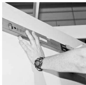
Ziehen Sie mit einem Stift und einer Wasserwaage in Höhe des Anschraubpunktes einen waagerechten Strich an der Wand.
