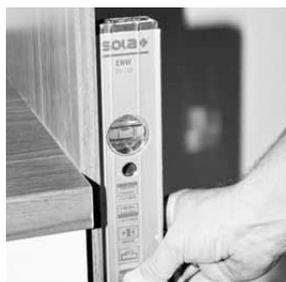
Alle Seitenschränke müssen zur Erhöhung der Standsicherheit mit der dahinter liegenden Wand verbunden werden.
