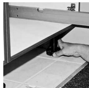
Zur genauen Ausrichtung der Möbelteile verdrehen Sie die Sockelfüße.
