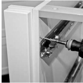
Da die Möbelteile mit einer Spaxschraube verbunden werden, müssen die Unterschränke zunächst vorgebohrt werden.
