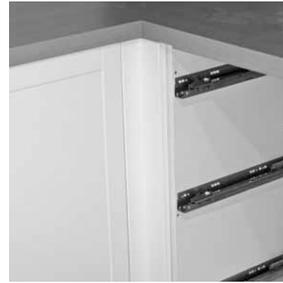
Achten Sie beim Verbinden der Passleisten mit 3 Spaxschrauben darauf, dass die Korpusvorderkanten bündig sind.
