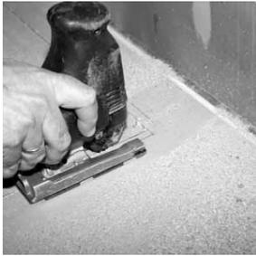
Anschließend schneiden Sie vorsichtig die Gehrungen mit einer Stichsäge aus.
