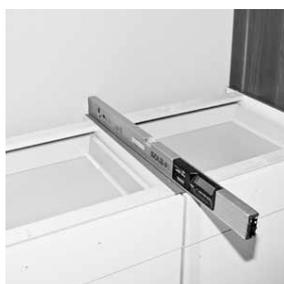
Richten Sie sämtliche Schränke in beiden Richtungen mit der Wasserwaage millimetergenau aus.
